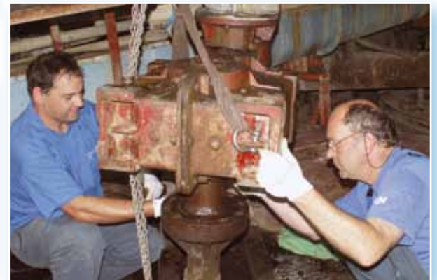
Üzembe helyezés, kiváltás, javítás / Installation, interchangeable solutions, overhauling
